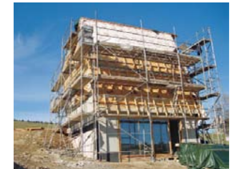
Am Fuße des Fichtelberges wird das Hauskonzept von Fasa an einem sonnigen Südhang umgesetzt. Erstmals setzt der Bauräger dabei eine Kombination aus Sichtbeton und massiver Holzbauweise ein. Auf dem Bild links ist der Platz für das fast 15 m 2 große Glaselement zu sehen. Rechts ist der passive Sonnenfänger bereits eingebaut. Das mittlere Foto zeigt das Gebäude von hinten und den beeindruckend weiten Blick zum Keilberg auf der tschechischen Seite des Erzgebirges.
