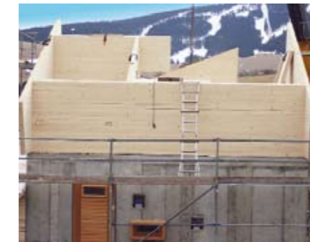
Am Fuße des Fichtelberges wird das Hauskonzept von Fasa an einem sonnigen Südhang umgesetzt. Erstmals setzt der Bauräger dabei eine Kombination aus Sichtbeton und massiver Holzbauweise ein. Auf dem Bild links ist der Platz für das fast 15 m 2 große Glaselement zu sehen. Rechts ist der passive Sonnenfänger bereits eingebaut. Das mittlere Foto zeigt das Gebäude von hinten und den beeindruckend weiten Blick zum Keilberg auf der tschechischen Seite des Erzgebirges.
