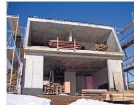
Am Fuße des Fichtelberges wird das Hauskonzept von Fasa an einem sonnigen Südhang umgesetzt. Erstmals setzt der Bauräger dabei eine Kombination aus Sichtbeton und massiver Holzbauweise ein. Auf dem Bild links ist der Platz für das fast 15 m 2 große Glaselement zu sehen. Rechts ist der passive Sonnenfänger bereits eingebaut. Das mittlere Foto zeigt das Gebäude von hinten und den beeindruckend weiten Blick zum Keilberg auf der tschechischen Seite des Erzgebirges.
