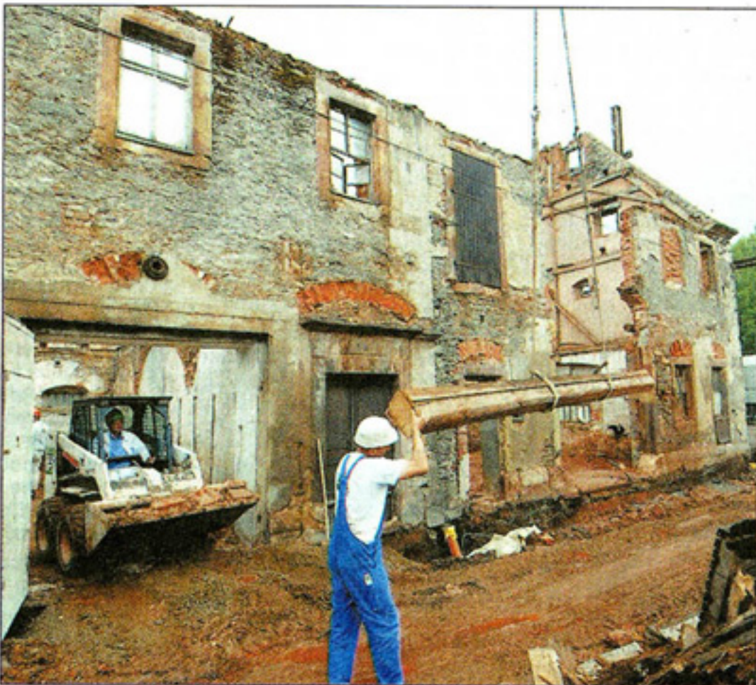
Am ehemaligen Rittergut in Rabenstein haben die Sanierungsarbeiten begonnen.
