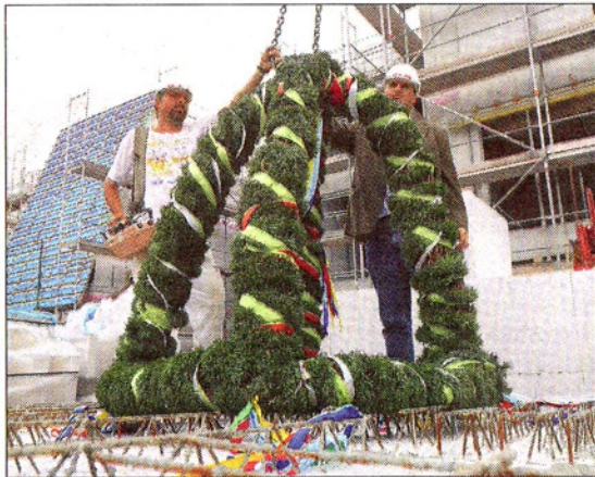
Kranführer Tino Erdmann (45) und Hochbau-Abteilungsleiter Henri Blanke (41, r.) hängen den Richtkranz an den Kran. Foto: Heyden
