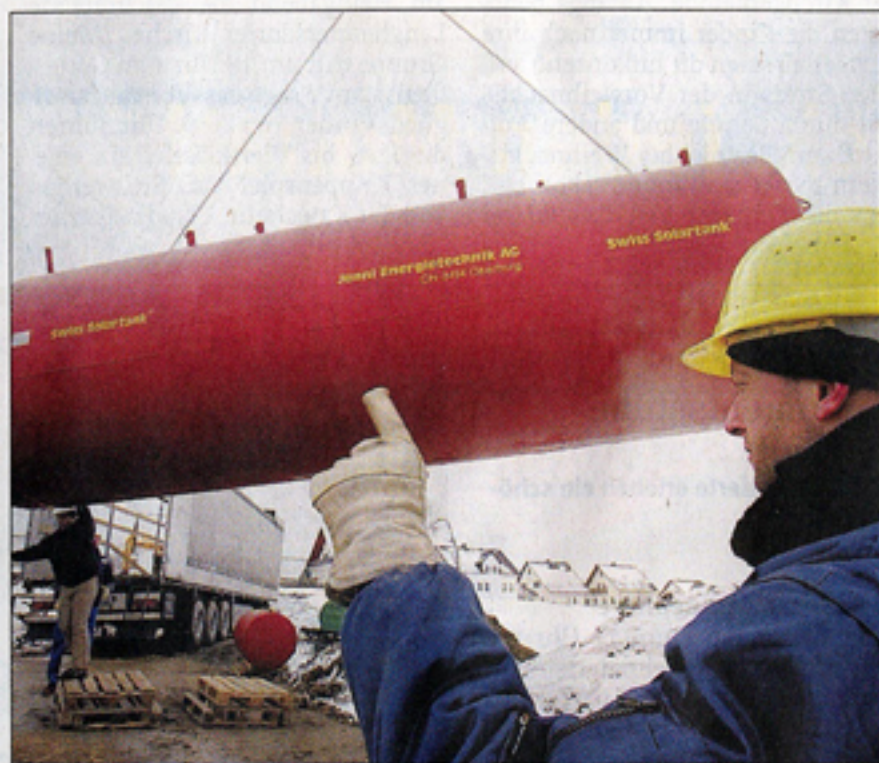
Kay Mine von der Firma Soli fer nahm den 7,30 Meter hohen Wasserspeicher für das Energetikhaus in Berthelsdorf mit in Empfang. Der Riesenspeicher fasst mehr als 28.000 Liter Wasser.
